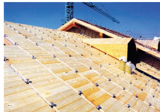
Realizzazione nuovo solaio con interposto in perlinato.
