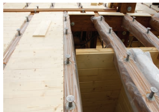
Nuova soletta con sistema H.S.B.
