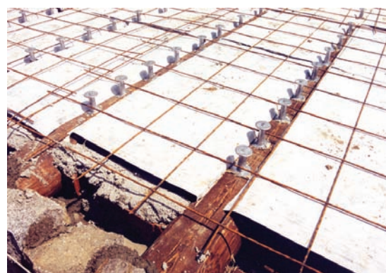
Recupero soletta con inserimento sistema H.S.B. su travi esistenti
